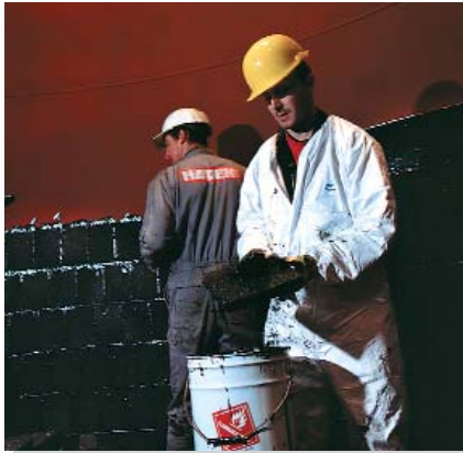
On applique le revêtement sur les tronçons de gaine au sol.
