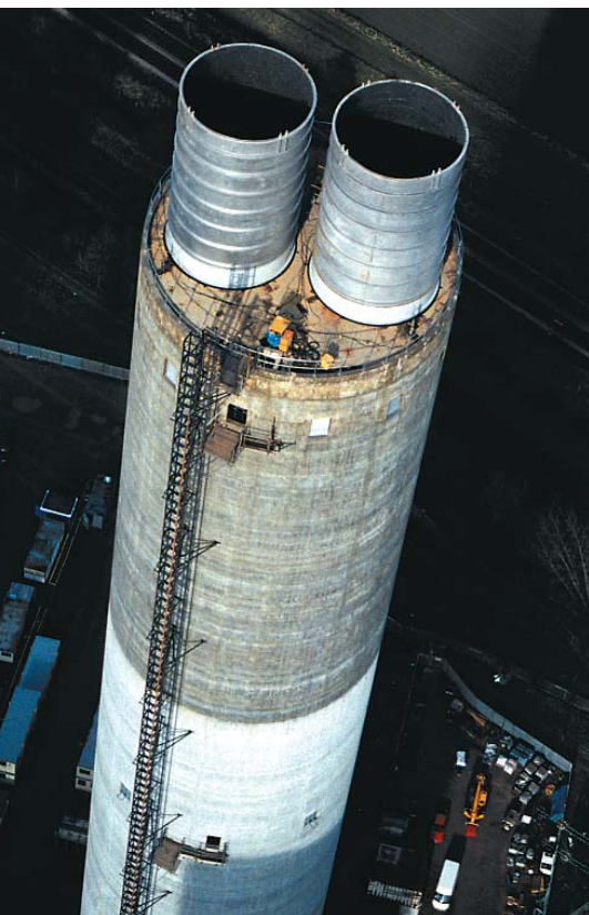
Une des nouvelles cheminées de 200m de hauteur, en aval de l'IDD.
