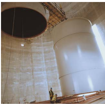
Un tronçon avec le revêtement Pennguard® entre dans la cheminée.
