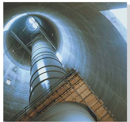
Une gaine de cheminée durant le processus d'érection.
