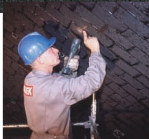
Inspektorzy przy pracy.
