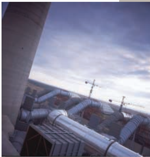
A kéntelenítő bemenő és kibocsátó füstcsatornái.
