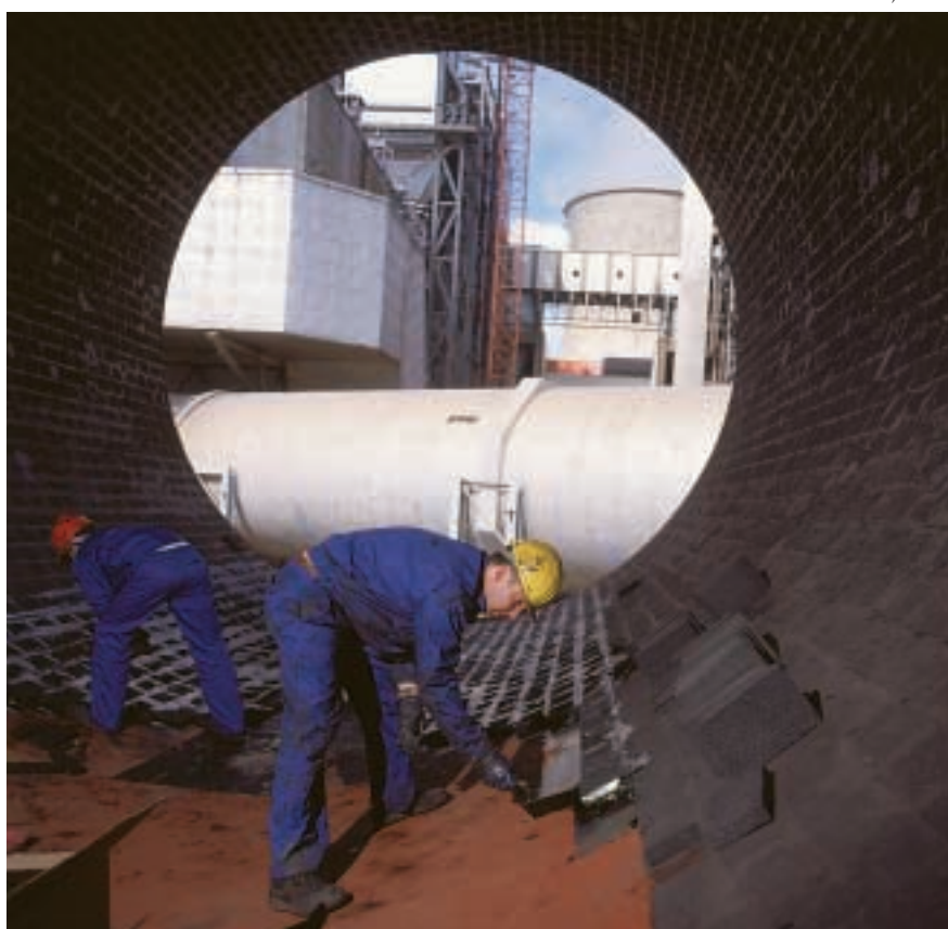
Průměr kouřovodů činí 6,2 m.
