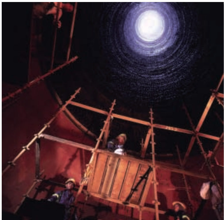
Widok jednego z przewodów stalowych po zainstalowaniu wykładziny Pennguard®
