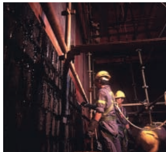
Nakładanie wykładziny w niższej prostokątnej sekcji jednego z przewodów.
