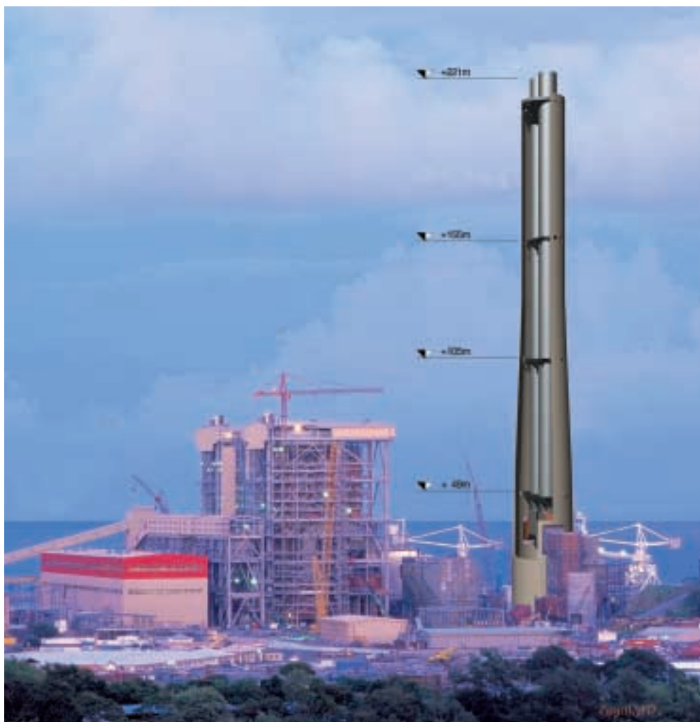
Komin żelbetowy z dwoma wewnętrznymi przewodami stalowymi.
