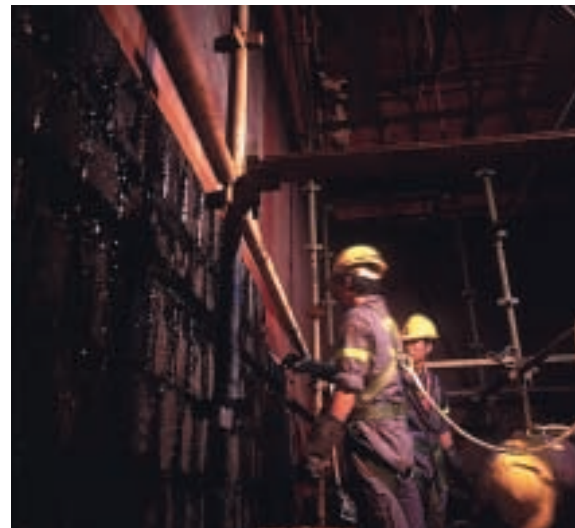
Az egyik füstcsatorna alsó részének bélelése.
