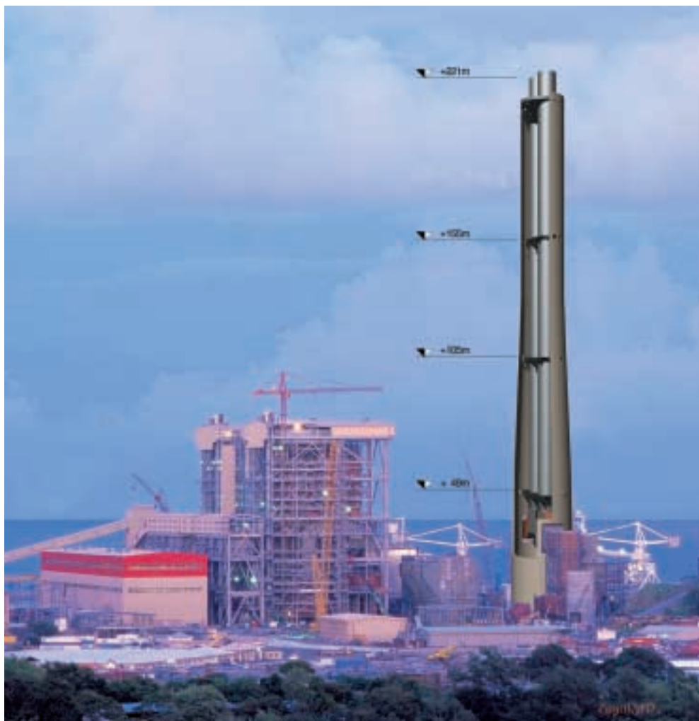
A vasbeton köpeny két acél füstgázcsatornát véd.
