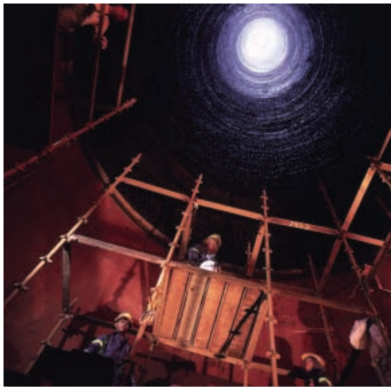
Az egyik Pennguard® béléssel ellátott füstcsatorna
