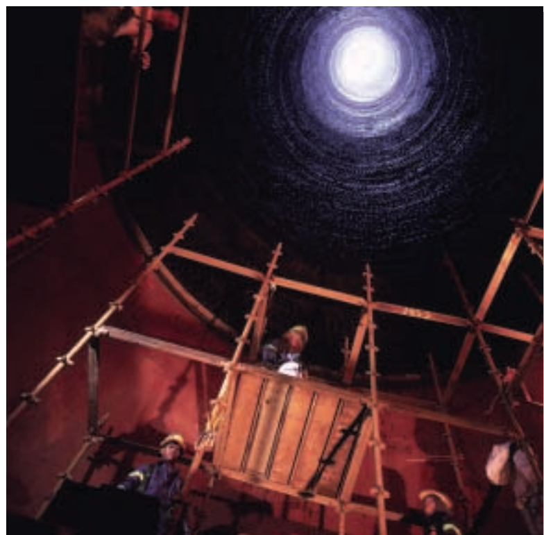
Ocelový sopouch po instalaci povrstvení materiálem Pennguard®.
