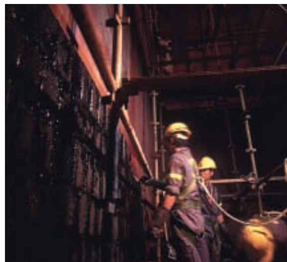
Aplikace na spodní část sopouchu s obdélníkovým průřezem.
