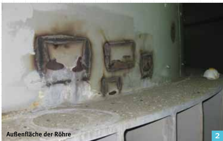
REA-Wet Stack mit zwei Stahlröhren
