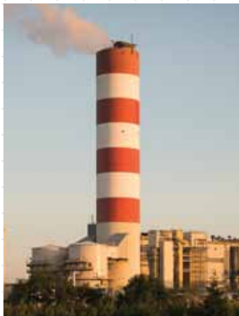
REA-Wet Stack mit zwei Stahlröhren
