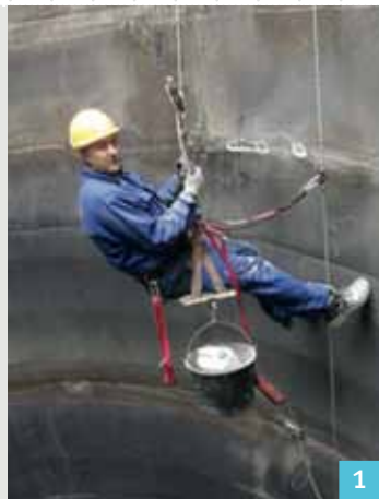
Reparatur der korrodierten Stahlflächen
