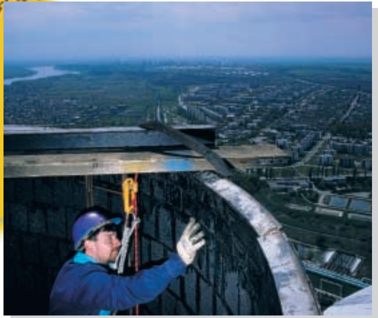
Die Mündung jedes einzelnen Rauchgaszuges ragt aus dem Betonschornstein heraus und ist äußerst empfindlich gegen Kältebrücken.
