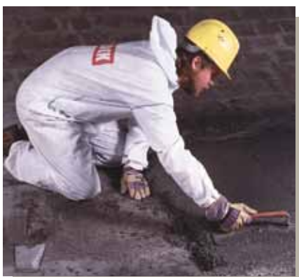
Der Schornsteinboden erhält einen zusätzlichen Schutz mit Tufchem-Zement.
