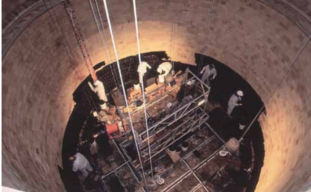
Die Arbeiten wurden von einer beweglichen Arbeitsbühne aus durchgeführt.
