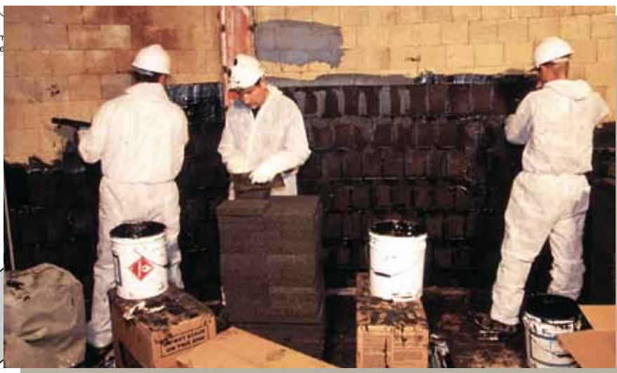
Erfahrene Mauer applizieren die Pennguard®-Auskleidung.
