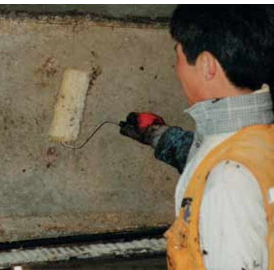
Penntrowel® Epoxy Primer seals the concrete surface
