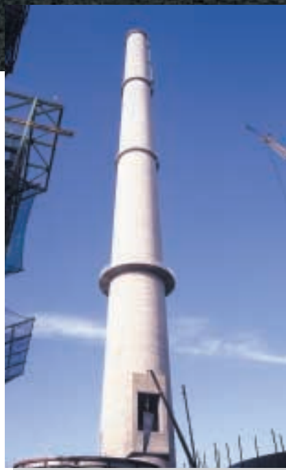
Coșul de la unitatea 6 în construcție
