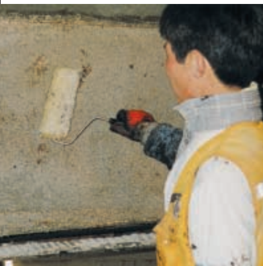
Etanșarea suprafețelor din beton cu Penntrowel Epoxy Primer
