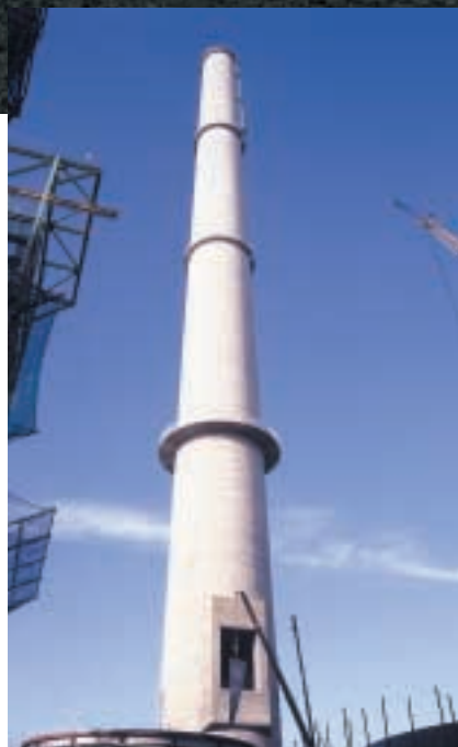
Komin bloku 6 w trakcie budowy
