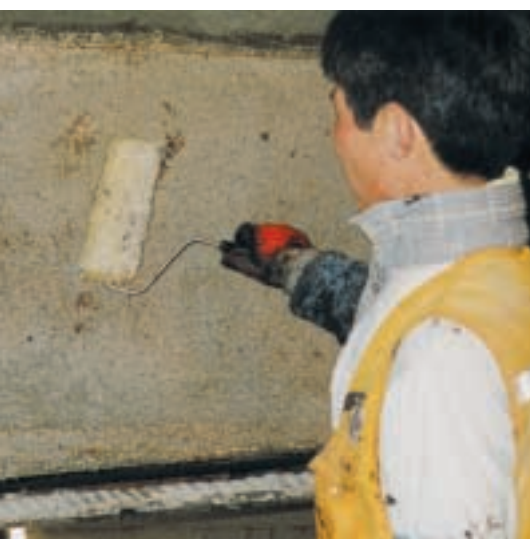
Gruntowanie powierzchni trzonu żelbetowego podkładem Penntrowel Epoxy Primer.
