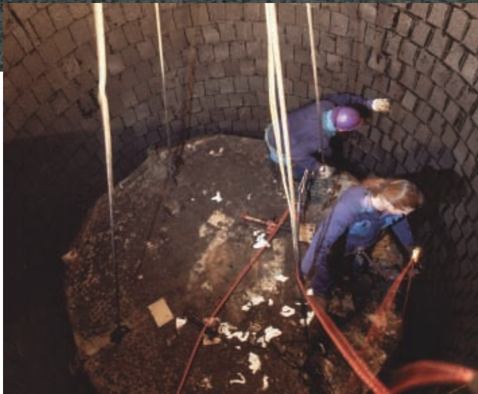
Osiągnięto wysoką jakość robót pomimo dużego zakresu robót i krótkiego czasu remontu.
