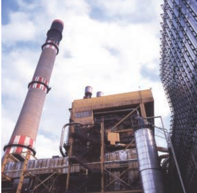
Jeden z 220 MW bloków energetycznych opalany olejem.
