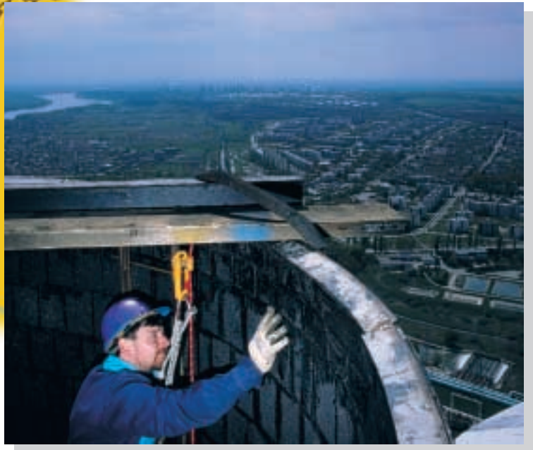
A füstgázcsatornák magassága meghaladja a betongyűrűt, így a hideg pontok szempontjából különösen érzékeny hely.
