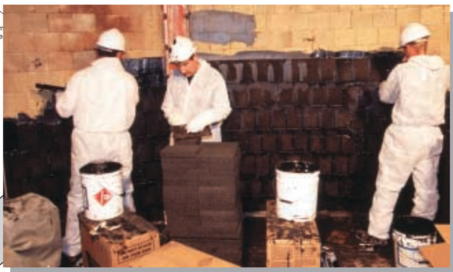
Nakładanie wykładziny Pennguard® przez przeszkolonych pracowników.
