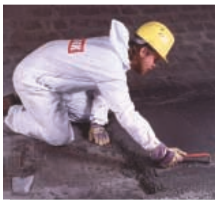
Posadzkę komina dodatkowo zabezpieczono ochronną warstwą cementu.
