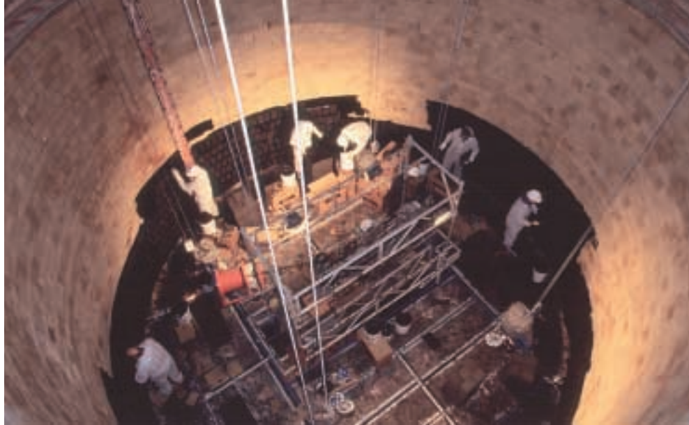
Wszystkie prace w kominie były wykonane z ruchomej platformy roboczej.
