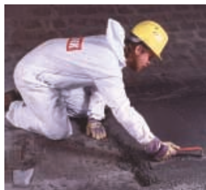
A kémény alja még egy réteg saválló bevonatot kap.
