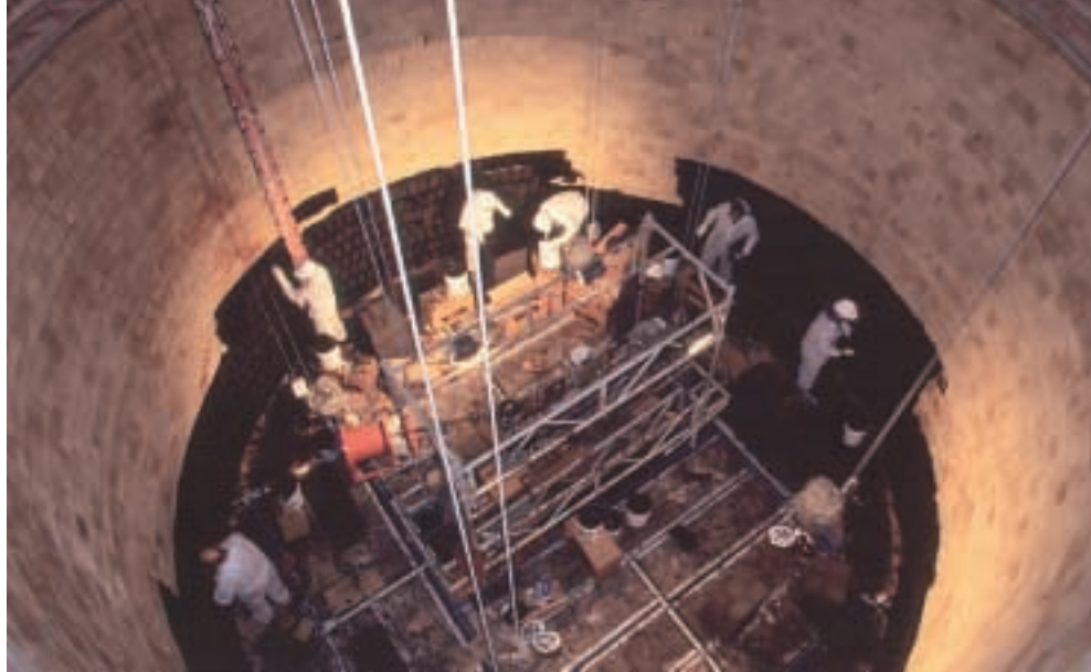
Veškeré práce na komíně byly prováděny z mobilní pracovní plošiny.
