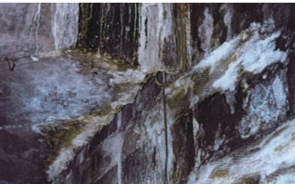
Kyselá depozita na zadní straně cihlové vyzdívky komína.
