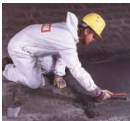
Podlaha komína byla opatřena přídatnou vrstvou kyselinovzdorného cementového potěru.
