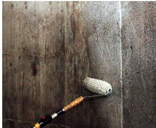
Figure 10: Application of the Penntrowel® Epoxy Primer
